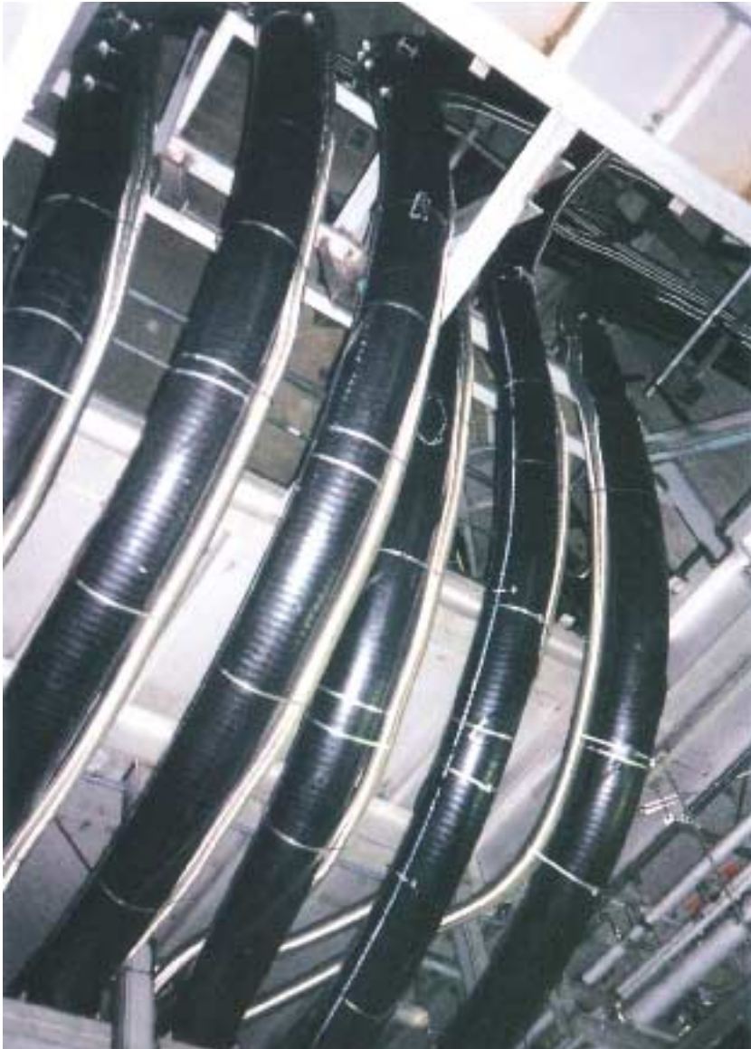
Helium Cryostat für supraleitende Kabel Helium Cryostat for superconducting Cables
