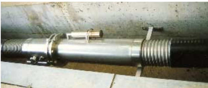
Kupplung einer CRYOFLEX®-Leitung im Schacht Coupling of a CRYOFLEX® Line in a ditch
